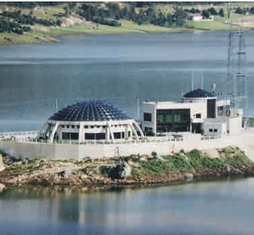
Servicio de inspección durante la construcción de la estación de bombeo y obras anexas del embalse San Rafael Colombia
